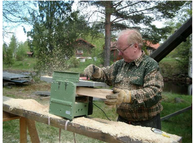
Med hjälp av den mobila elhyveln kunde Håkan Axelsson göra passbitarna med exakt rätt tjocklek.
