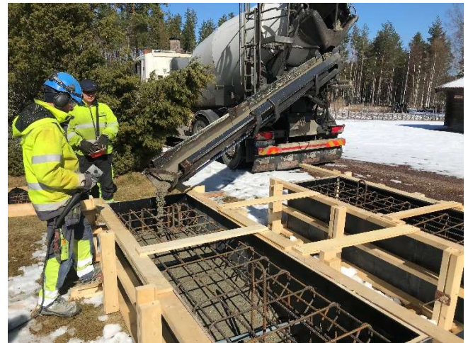
Gjutning av grundsulor.
