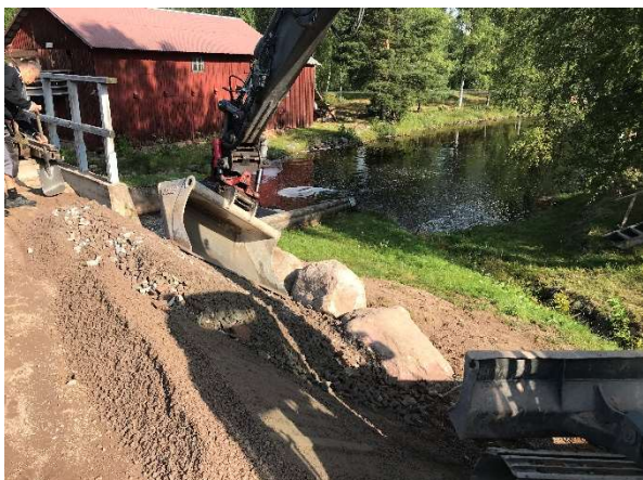
Filter, övergångslager och stenblock på nedströmsslänten.
