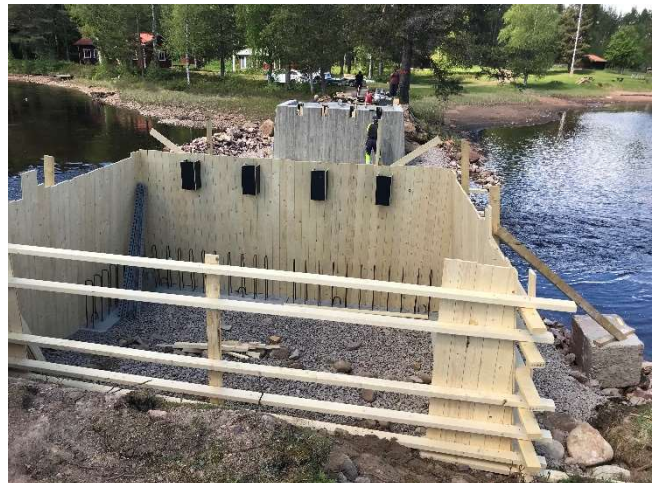
Formsättning östra landfästet.
