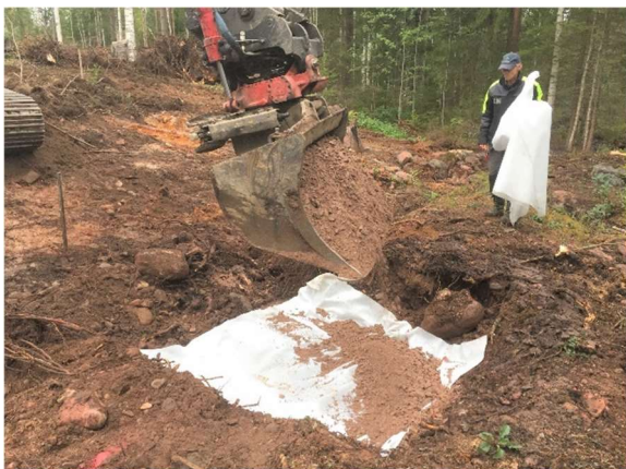
Grusfyllning på fiberduk.
