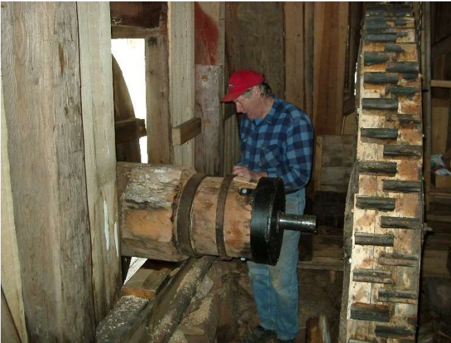
Östen Sahr kontrollerar att axeln går fritt.
