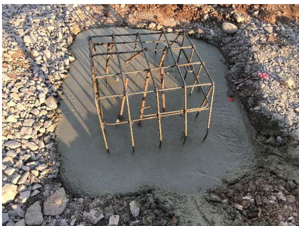
Första gjutetappen för spelfundamentet.
