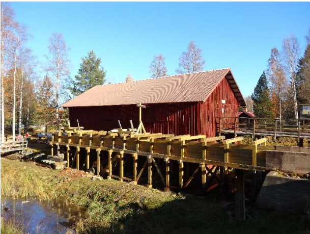
Färdig ränna. 12 okt 2013.
