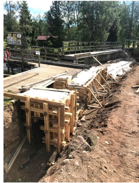
All gjutning klar och plasttäckt.
