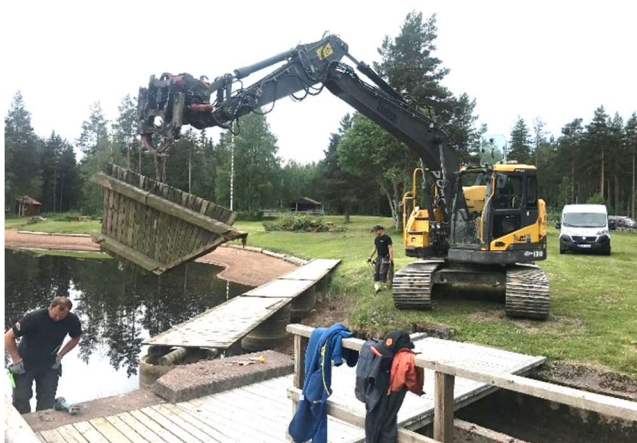
Arbetet påbörjas med demontage av badbrygga.
