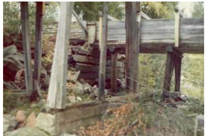
Före ombyggnad. Rännan in till sågen i bakgrunden.
