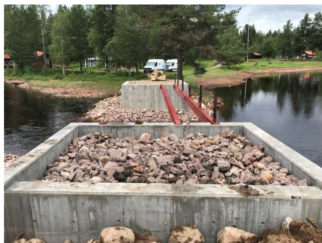
Östra landfästet fyllt med sten. Efter utläggning av fiberduk kompletterades med väggrus.
