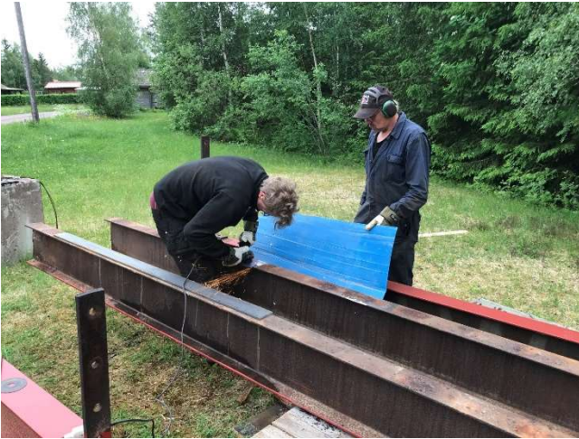
Förstärkning stålbeakar med plattstål.
