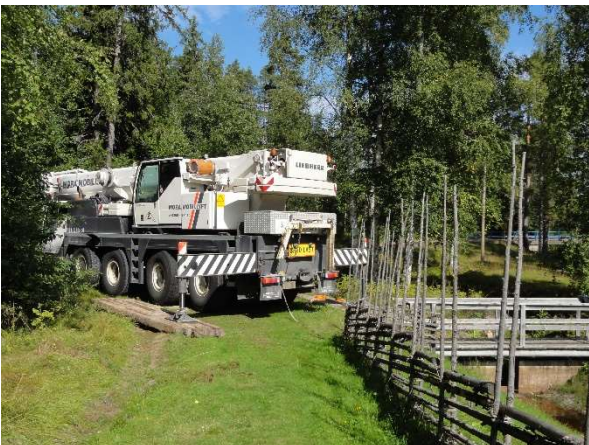
Mobilkranen uppställd. 21 aug 2013.
