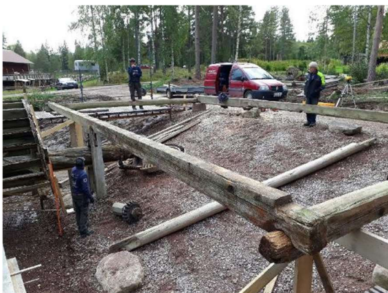
Första stockvarvet provisoriskt utlagt.
