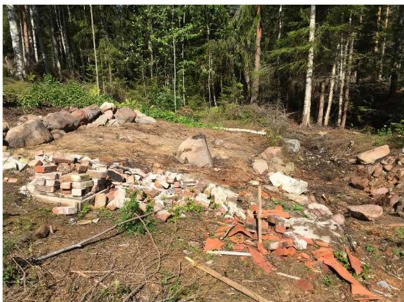
Den gamla grundläggningen. De två upplagsstenarna för axeln syns mitt i bilden och till höger.
