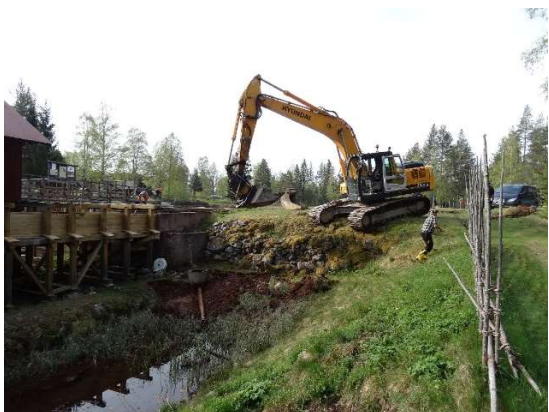
Befintlig slänt. Brunn med utloppsledning frilagd.
