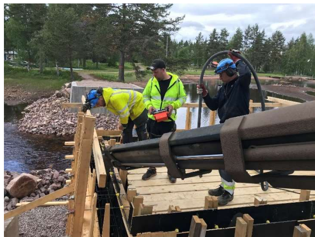
Gjutning östra landfästet kunde göras med ränna.
