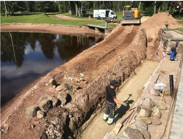
Packning tätjord på schaktbotten.
