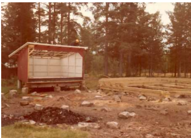
Gamla dansbanan riven. Dansbanekuren under rivning. Stomme för ny dansbana påbörjad.
