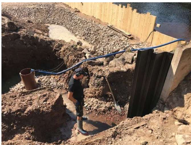
Fortsatt spontmontage. Pumpbrunn för länshållning.
