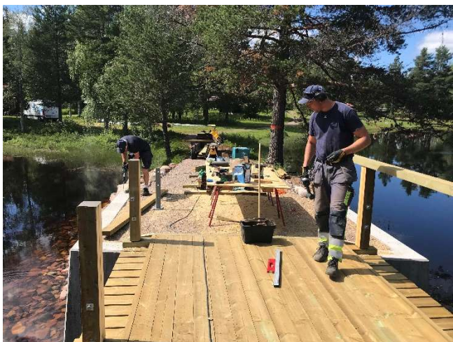
Montering överliggare och borming för yttre stolpar.
