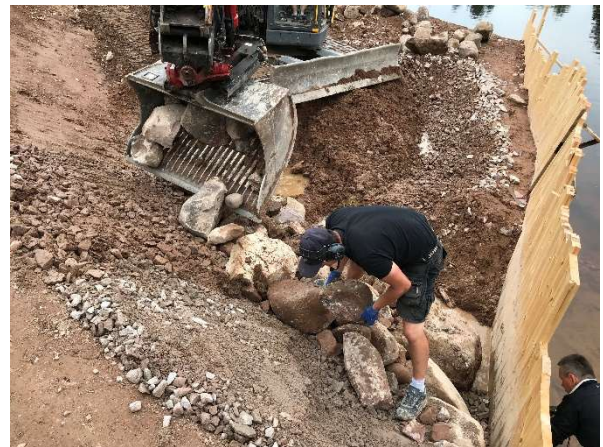
Påbörjande av erosionskydd uppströms.
