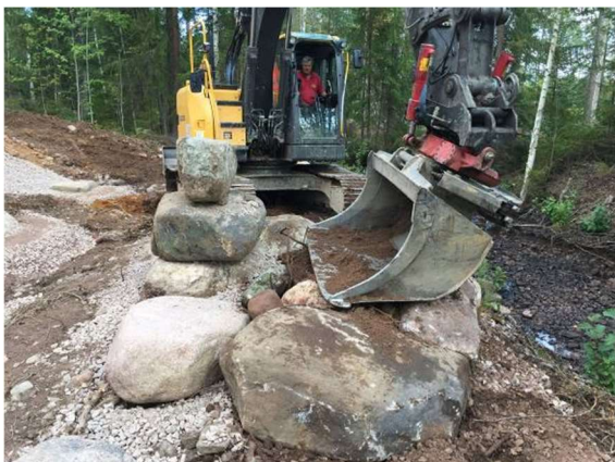
Upplag för höger axelände under utförande.
