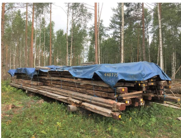
Timmerstommen upplagd under tak.
