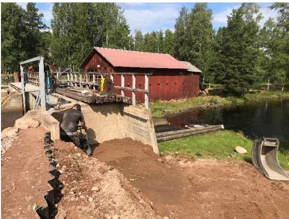
Packning av tätjord i pelaren.
