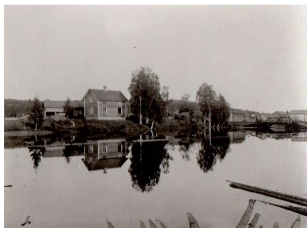
Dammen. Längst till höger syns den gamla bron med överliggande fackverk.
