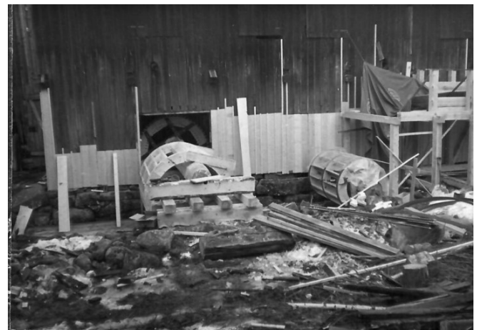
Vattenhjul till kantverk överfalls och samning överfalls hjul. meg 25
