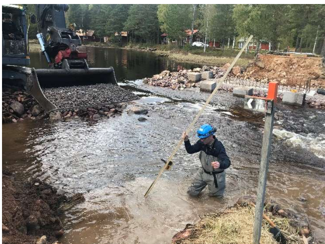
Avvägning och justering av botten för grundsulorna.
