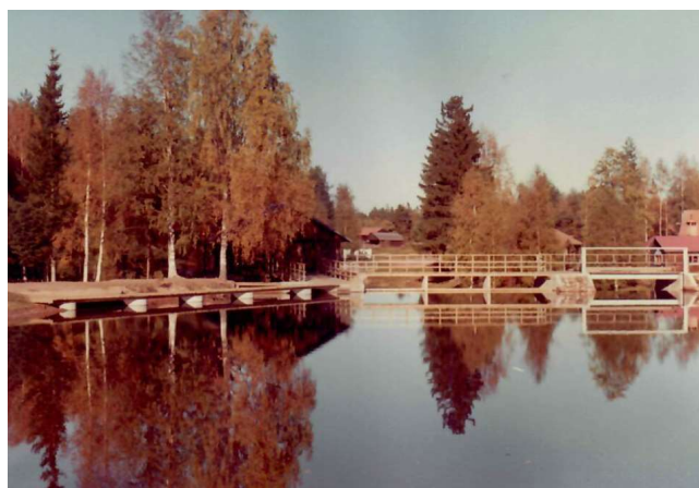
Dammen uppfylld efter renoveringen. Badbryggan byggdes om med upplag på betongbrunnar.
