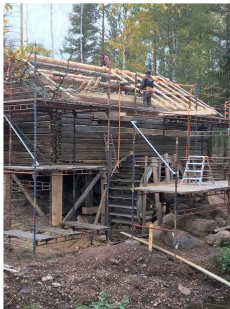
Montering takreglar östra takhalvan.
