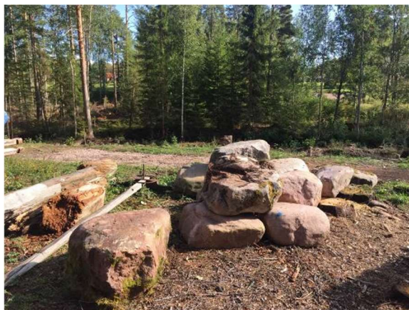
Hämtade stenblock för grundläggning.
