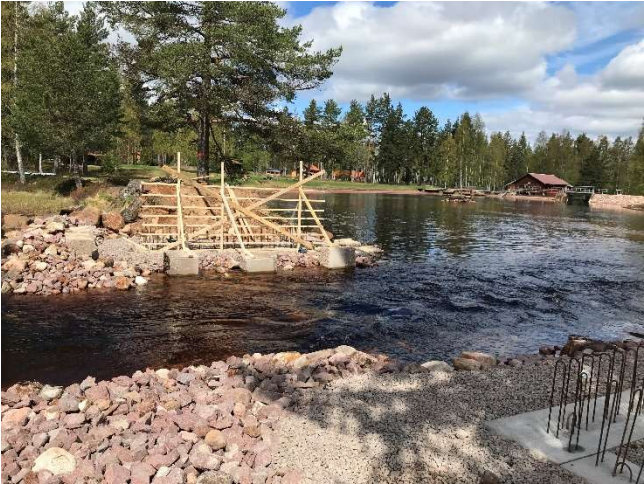
Formsättning västra landfästet påbörjad.
