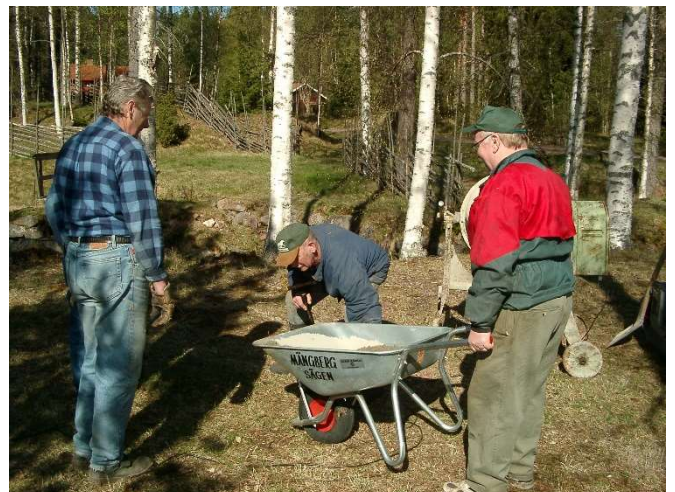
2003-05-10. Östen Sahr, Kjell Uhläs och Håkan Axelsson blandar betong.
