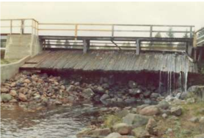
Skibordet före ombyggnad.
