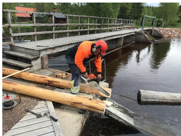
Börje fasar av stockändarna, så att timret inte ska fastna.
