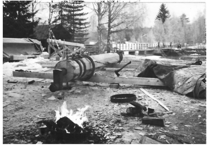
Axel för ramsåg. Ringarna värms i elden innan de förs på, så att de efter avsvälning sitter hårt.
