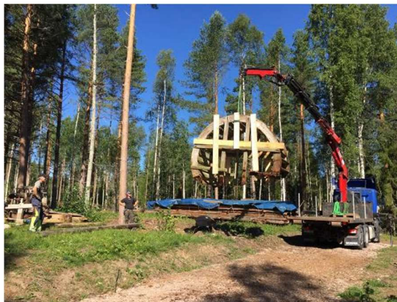
Vattenhjulet förstärktes provisoriskt för att kunna flyttas.
