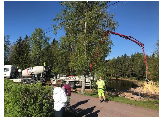
Gjutning västra landfästet med pump från östra sidan.
