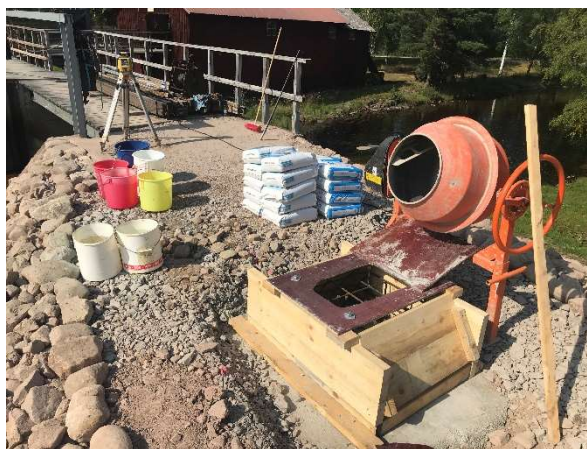
Gjutning av andra etappen.
