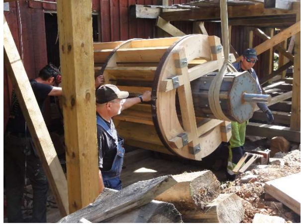
Axel med vattenhjul på väg att läggas ner i det yttre lagret. 21 aug 2013.
