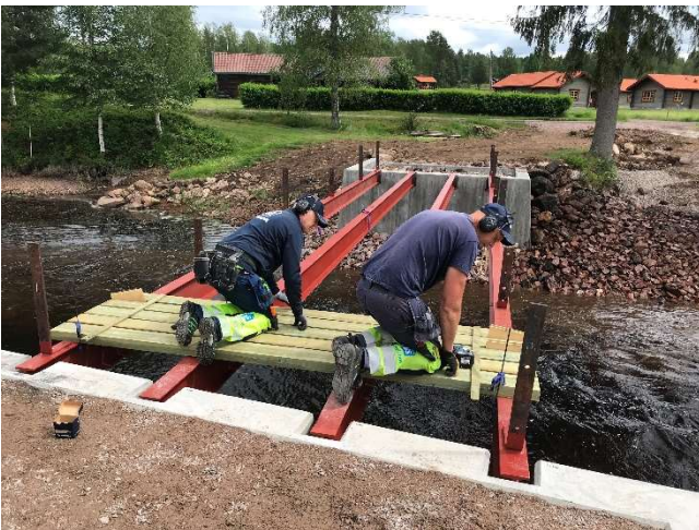
Montage träöverbyggnad påbörjad.
