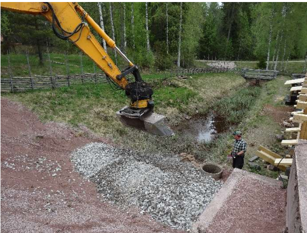
Utläggning av grovfilter.
