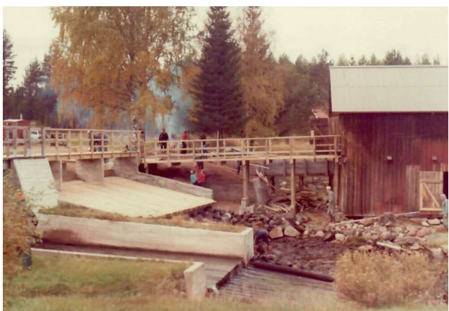
Nytt skibord och ny brygga in till sågen.
