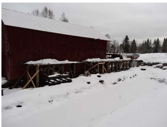
Arbete utfört under hösten 2012. Den nya rännans stomme nedströms ifrån. Jan 2013.
