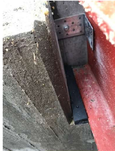
Balkarna ligger på glidlager av Robalon och är även styrda i sidled med Robalon och vinkelstål.
