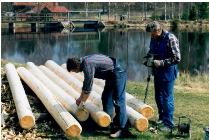
Bertil Olsson och Östen Sahr borrar hål i stockarna för sammanbindning med kättingar.
