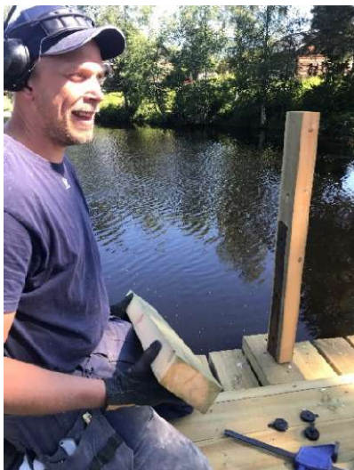
Räckesståndarna i form av 2 st 2½x5" fästes i plattstål svetsade i stål balkarna. Plattstålen frästes in i den ena regeln. Ståndarna monterades med ca 1 cm spel mot underlaget.
