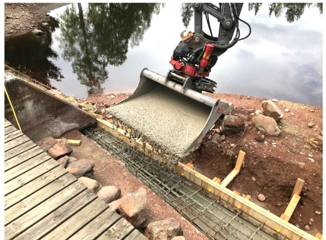
Betongen tappas ur skopan.
