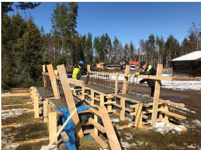
Montering av uppstickande armering.
