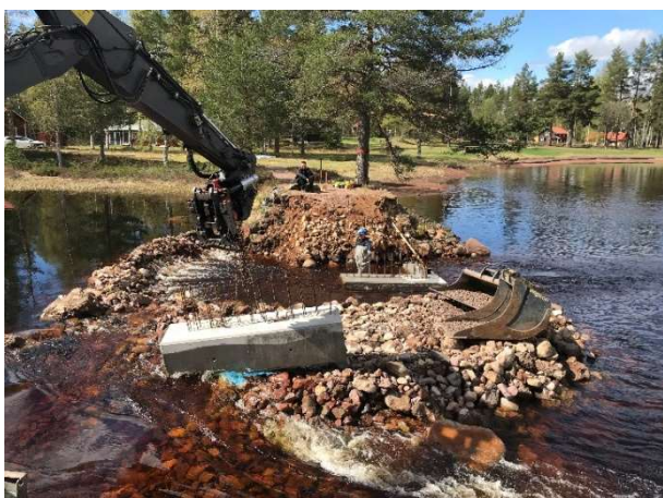
Grundsulorna lyfts på plats.
