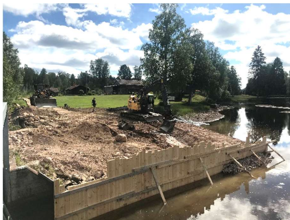
Spontfångdamm och moränfångdamm.
