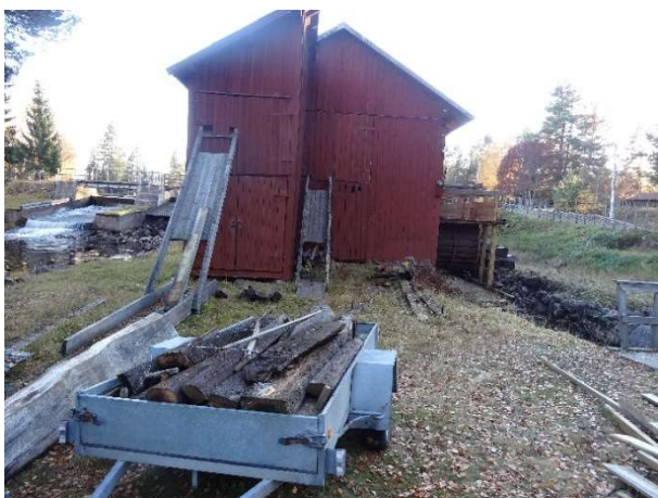
Bortforsling av virke från den gamla rännan genom eget arbete. 14 okt 2013.
