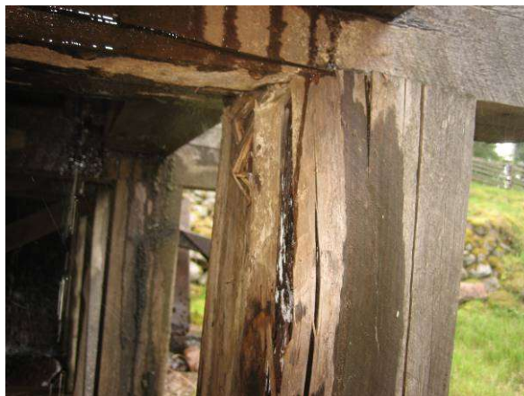
Stolparna var delvis mycket murkna
