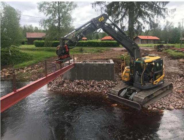
Montage balkar med grävmaskin.
