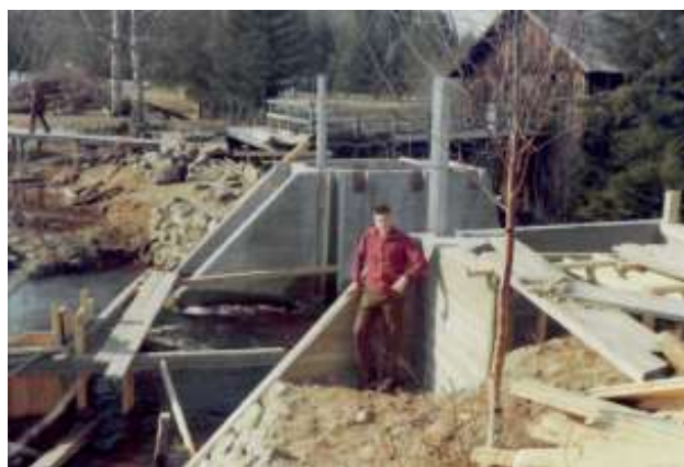
Båda pelarna gjutna. För utförande av tröskeln ledde vattnet genom vänster pelare. Fäbodlagets första ordförande Göte Halvarsson.
