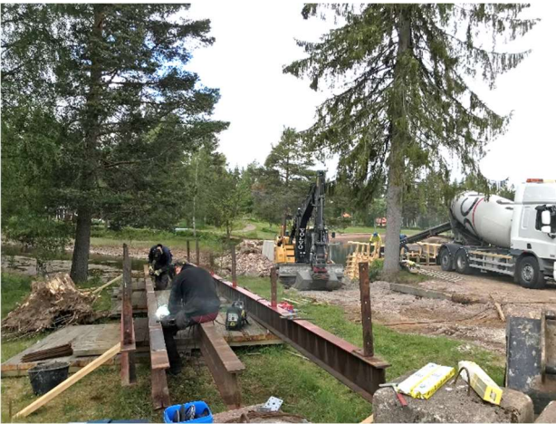
Förstärkning balkar och gjutning östra landfästet.
