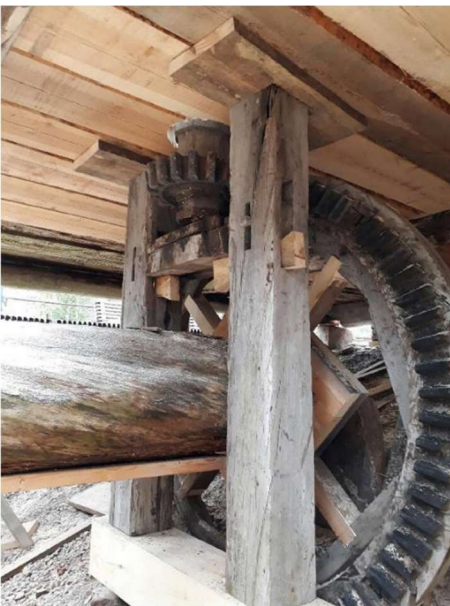
Kugghjulet på axeln från vattenhjulet och kugghjulet som för upp rotationen genom golvet monterade.
