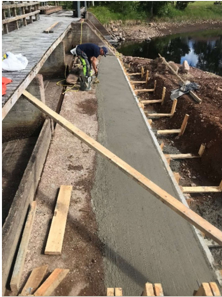
Slutfinish balken uppströms skibordet.
