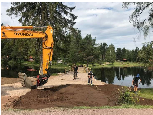
Utläggning matjord på östra sidan.
