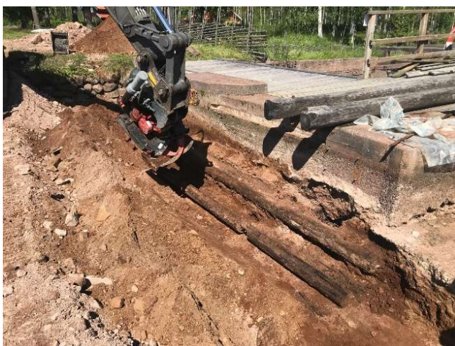
Vid schaktarbetena måste timmerresterna från den ursprungliga dammen schaktas bort.
