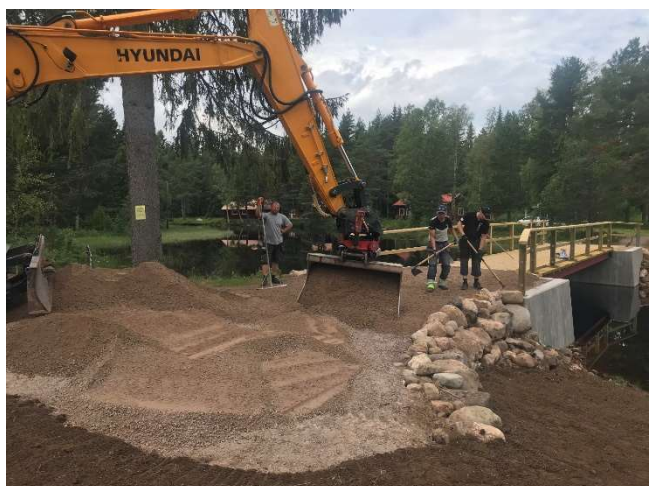
Utläggning väggrus på östra sidan.
