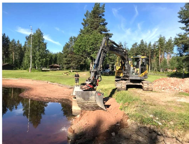
Start utläggning fångdamm.
