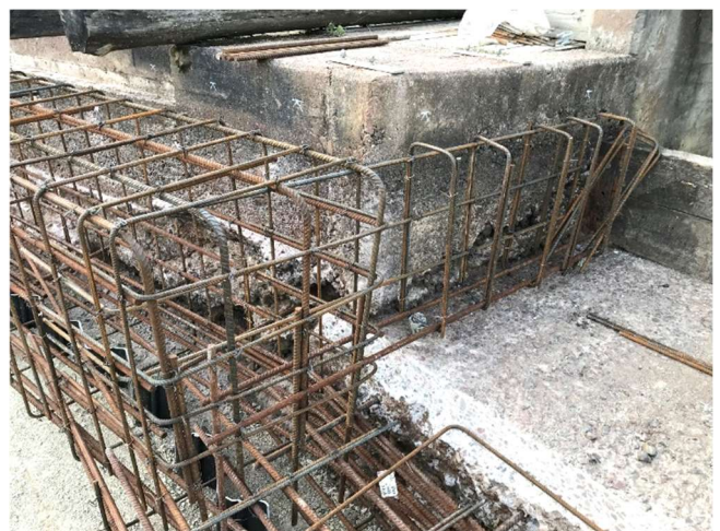
Armering vid ena läckagestället.
