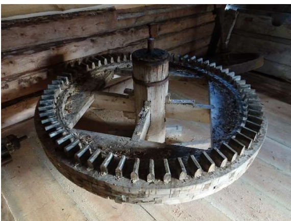
Kugghjulet ovan golv. Fotot visar även de nya breda golvplank som ersätter de gamla golvplank som var rötskadade.
