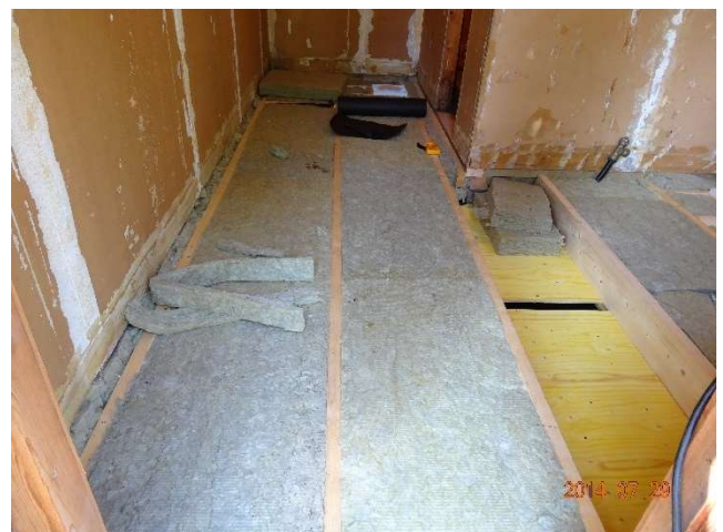
Isolering av bjälklaget.
