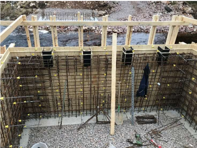
Armering västra landfästet. Observera balkupplagen.
