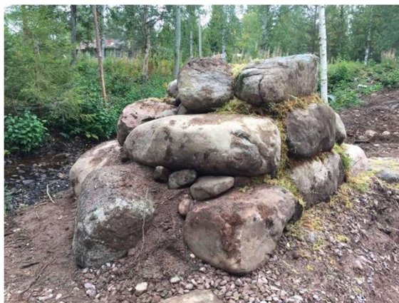
Mindre stenar kilades in för att stabilisera de större blocken. Mossa stoppades sedan in i "fogarna".
