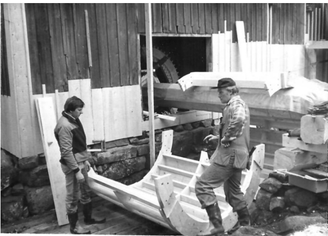
Vattenhjul till kantverk John Erik Stoltz Palle Blom meg 20
