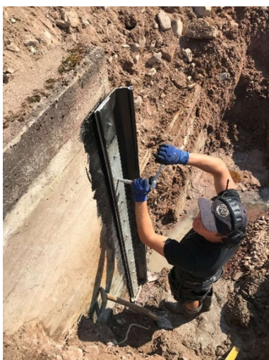
Första spontplankan fixeras mot betongen med mellanlägg av Syncoflex.
