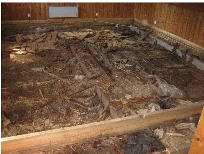
Golvet och trossbotten upprivna. Bl a hade en grävling gjort sig hemmastadd under golvet.
