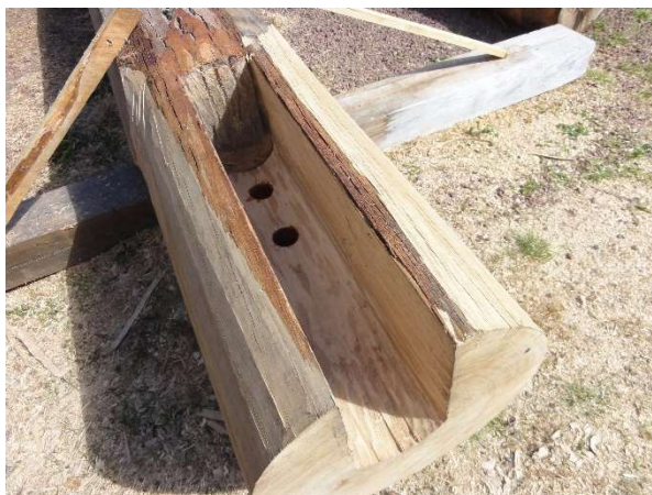
Ursparning för infästning vevslänga. 20 juli 2013.
