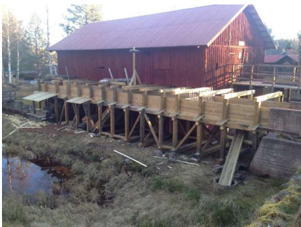
Rännan kompletterad med tak över axeländarna och stockändarna. Foto 17 nov 2013.
