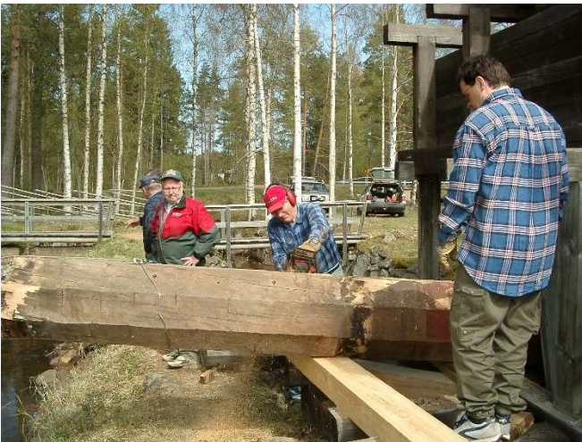
Axeln kapas till hanterliga bitar.
