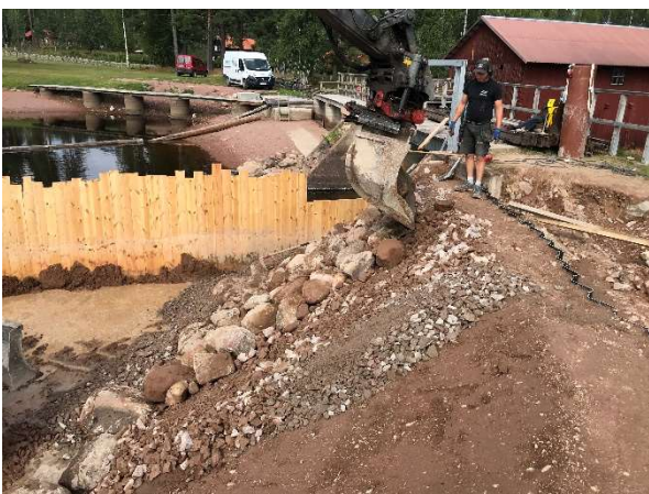
Övergångslager och stenblock på uppströmsslänten.
