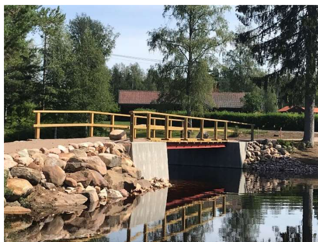
Färdig bro från uppströmssidans vänstra strand.
