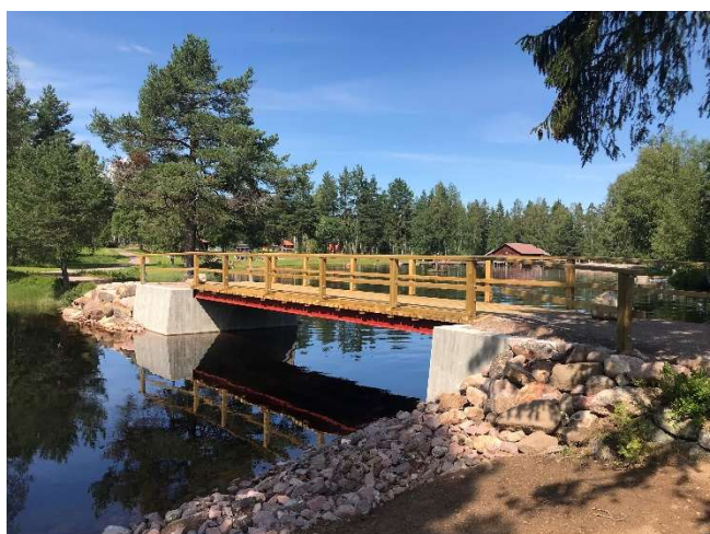
Färdig bro från uppströmssidans högra strand.
