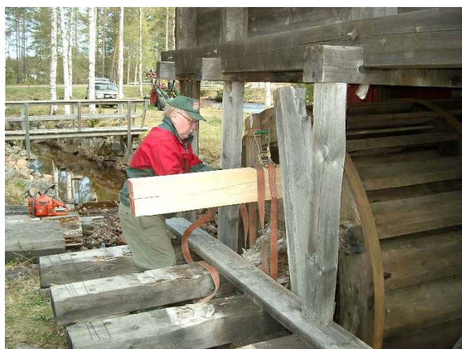
2003-05-09. Håkan Axelsson förbinder axeln med en utskjutande regel.
