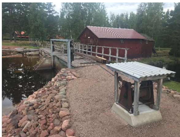
Spelet monterat och dammen under uppfyllnad.
