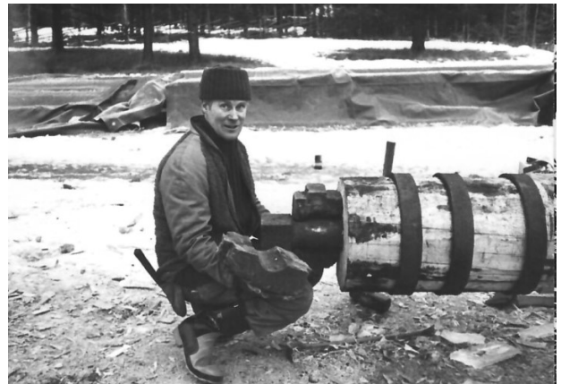
Putte Bohm visar inre lager för axeln till underfallshjulet.
