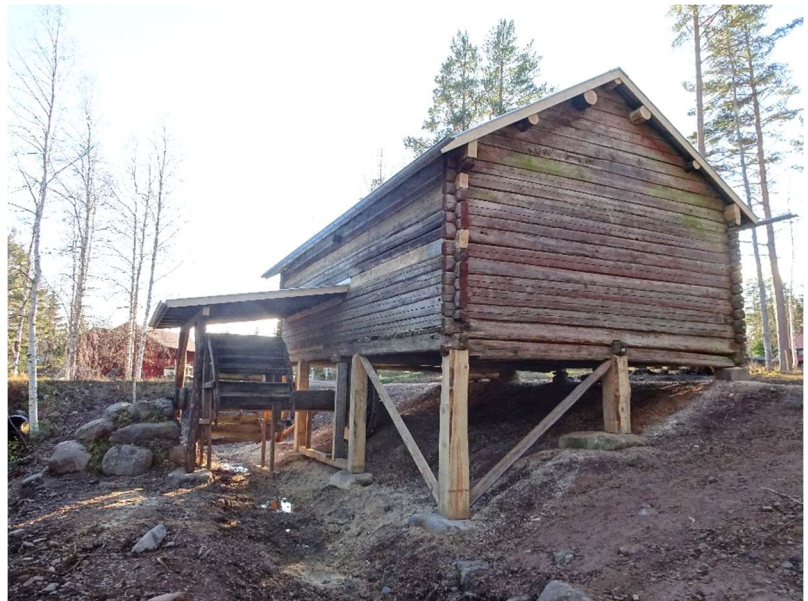
Färdigställd träsklada. Östra och södra väggen.
