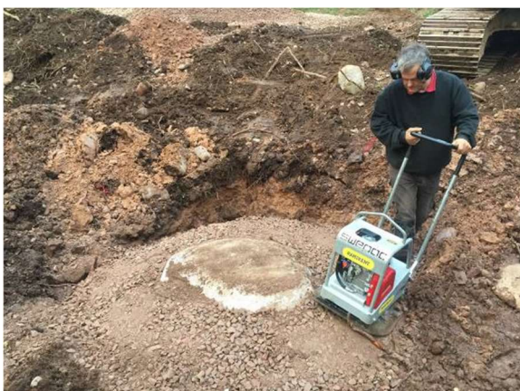
Packning även efter kringfyllning.
