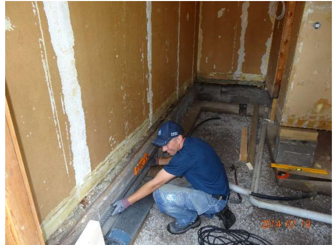
Det gamla golvet revs bort.
