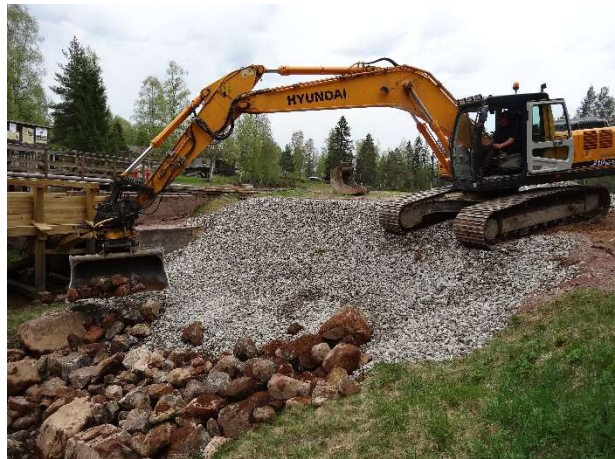
Utläggning av stenspäls.
