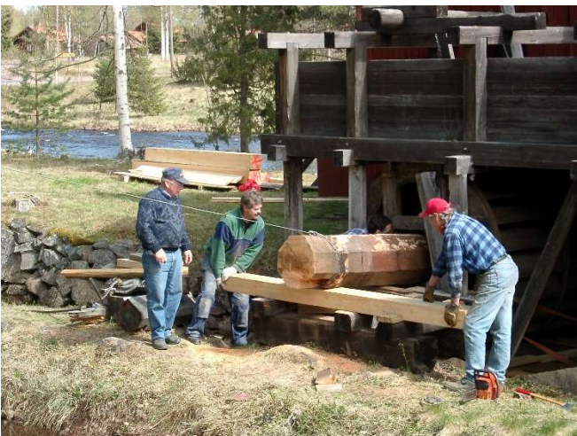
Axeln drogs ut med hjälp av vajer från traktorn.
