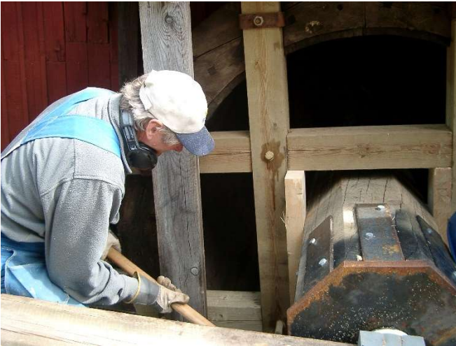
Axeln fixeras mot vattenhjulet av Östen Sahr.
