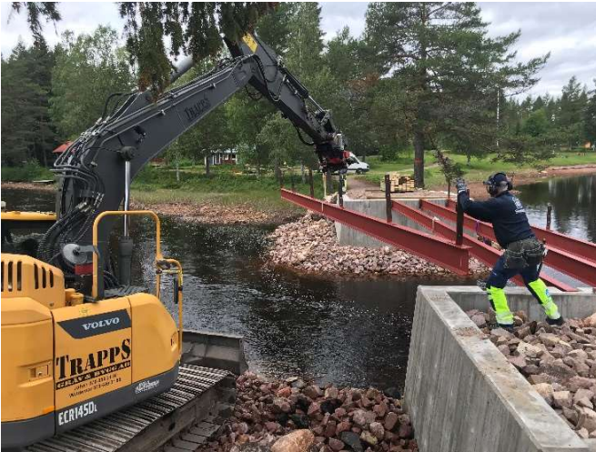
Fjärde balken monteras.
