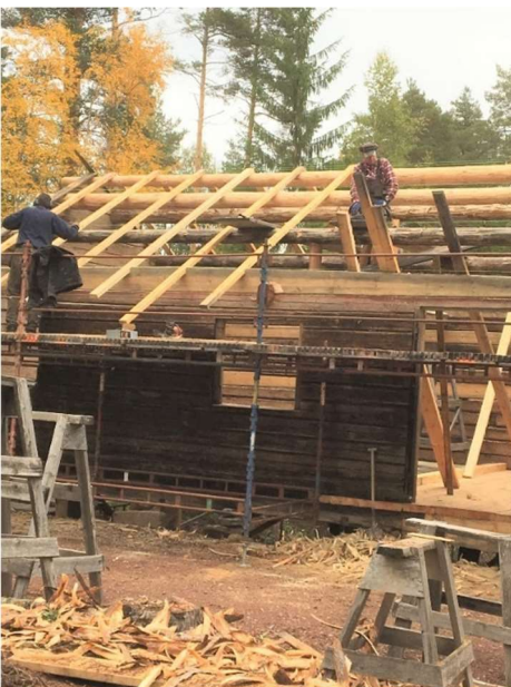
Montering takreglar västra takhalvan.
