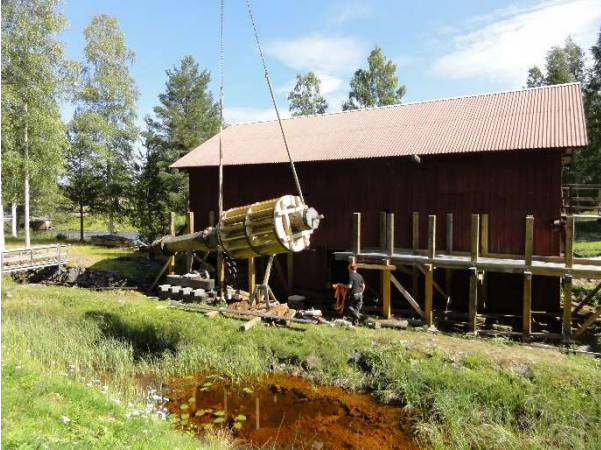
Axel med vattenhjul på väg mot rännan. 21 aug 2013.
