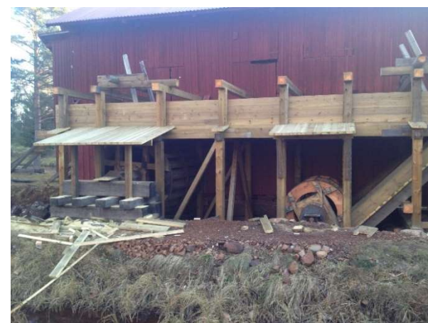
Taken över axeländarna. Stödning återstår.
