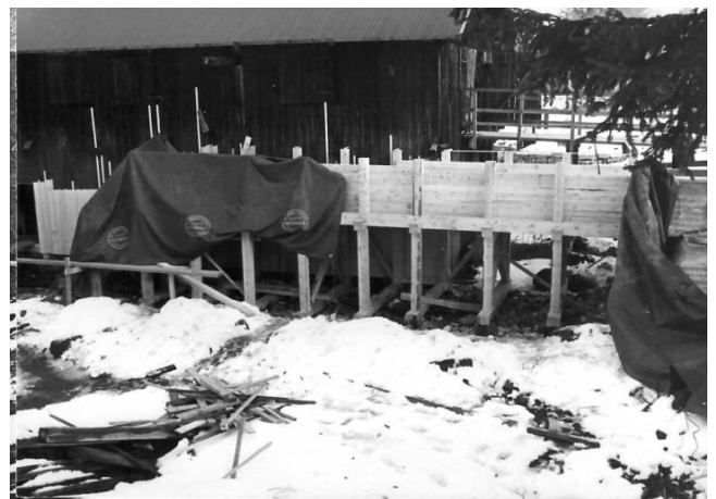
Den nya rännan under uppbygggen axel maj 16
