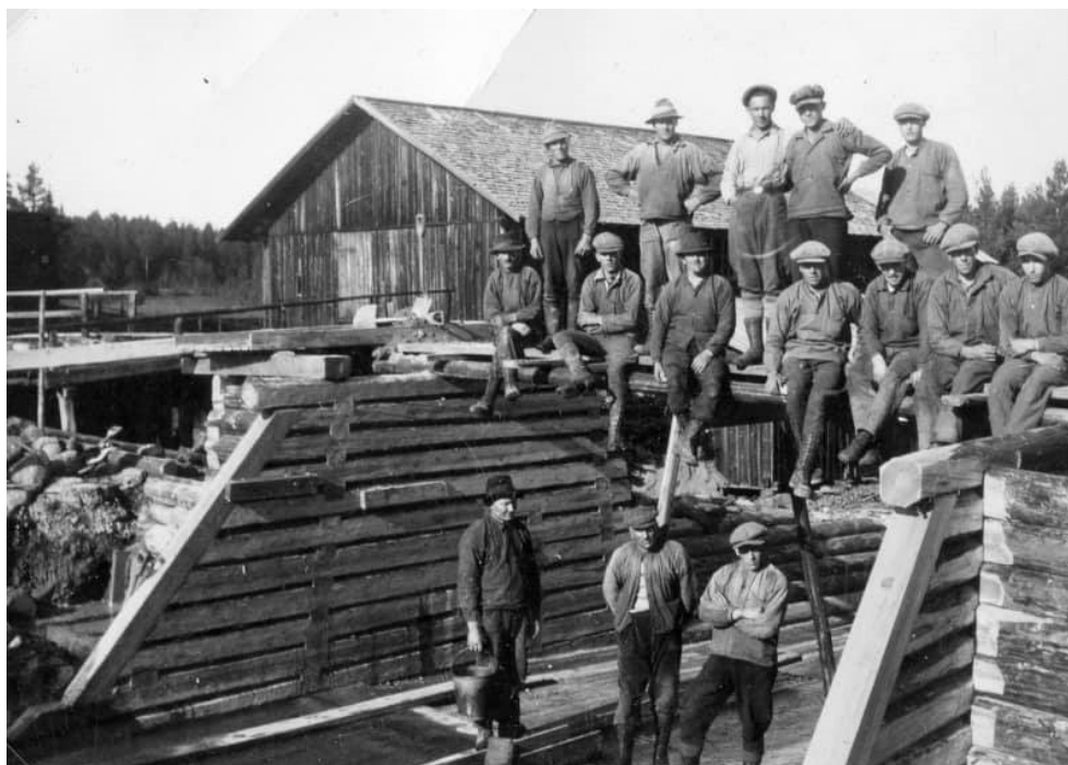
Bild från ombyggnad av flodutskovet 1921.
