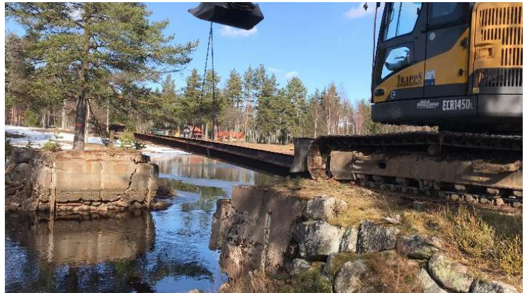
Demontering av stålbalkarna med grävmaskin.
