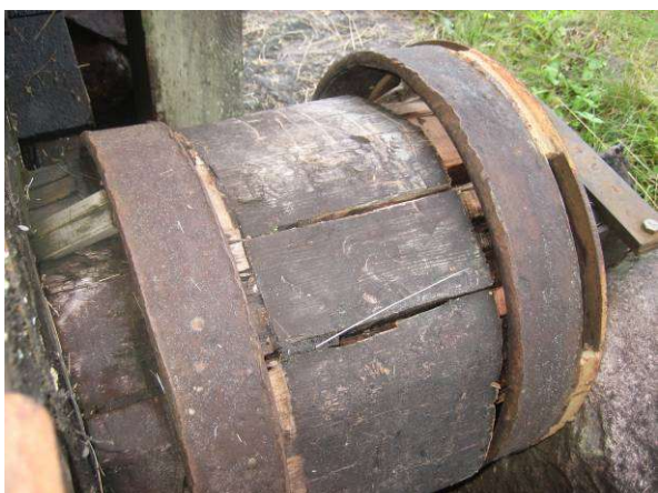
Vid sågdagen 2010 gick infästningen för den yttre lagertappen i axeln för underfallshjulet sönder.
