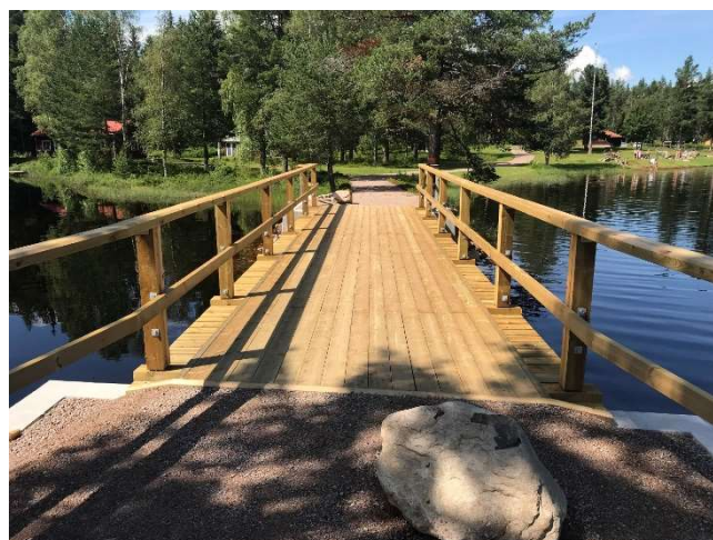
Grusfyllningen klar och stenblock utlagda för att förhindra biltrafik över bron.
