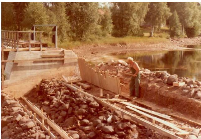
Formsättning för upplag för skibord. Nils Myhr slår ner träspons för tätning i dammlinjen.
