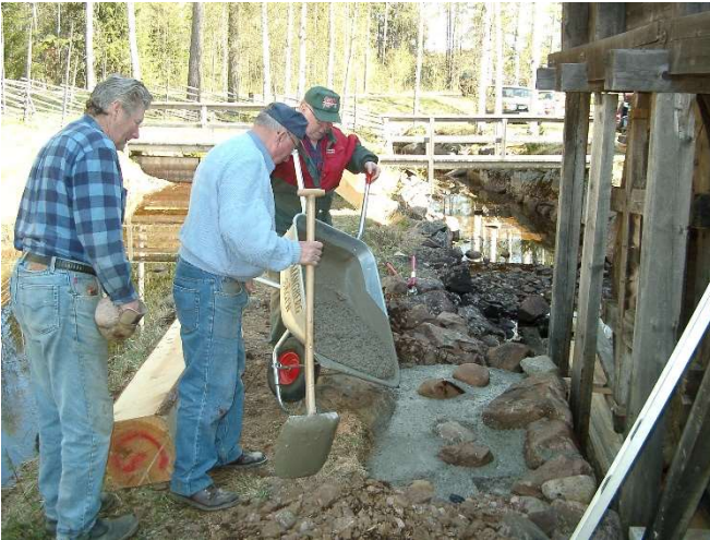
Gjutning av upplag för nytt axelfundament. Bror Olsson hanterar skyffeln.
