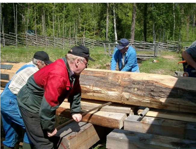
Baxning av axeln på rullar av vattenledningsrör.
