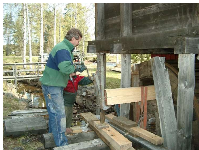
Bertil Olsson lyfter upp axeln med hjälp av den utskjutande regeln och en vevdomkraft.
