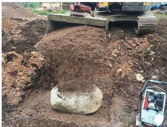
Kringfyllning av block som lagts på den packade fyllningen.
