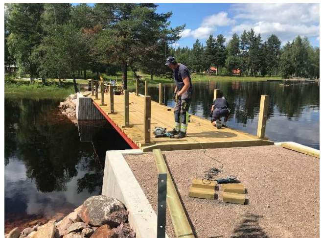
Plankorna vid broändarna monterade och montage räcesstolpar pågår.
