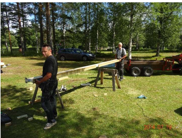
Golvbjälkarna "prefabricerades" med upphängningsbeslag och upplag för trossbotten.
