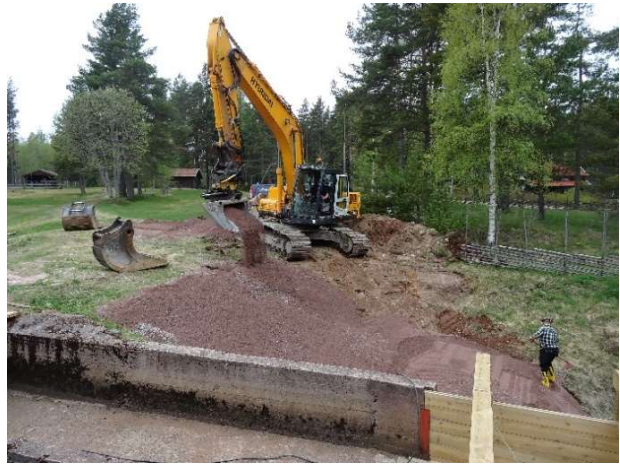
Finfilter läggs ut.
