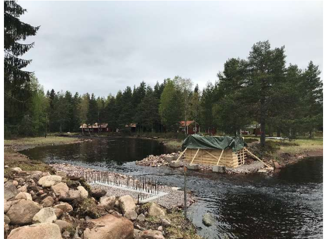
Fortsatt formsättning och armering västra landfästet.
