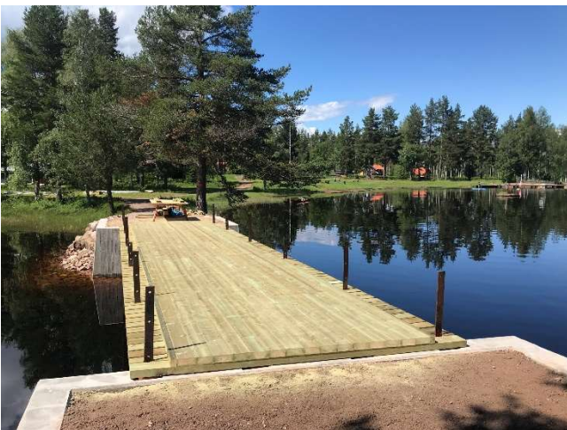
Även övre lagret klart så när som på plankor på högkant vid broändarna.
