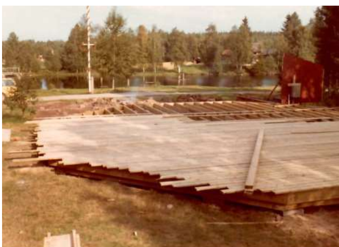
Utläggning trall påbörjad.
