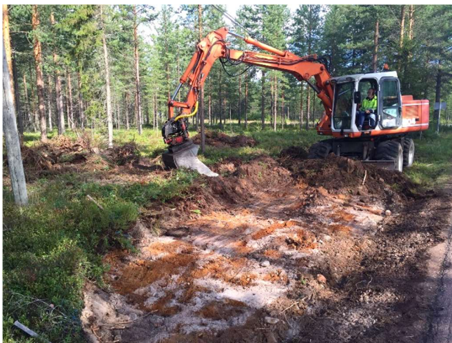
Ytan för brevlådeuppställningen schaktas av. Stubbarna grävdes ner i skogen.
