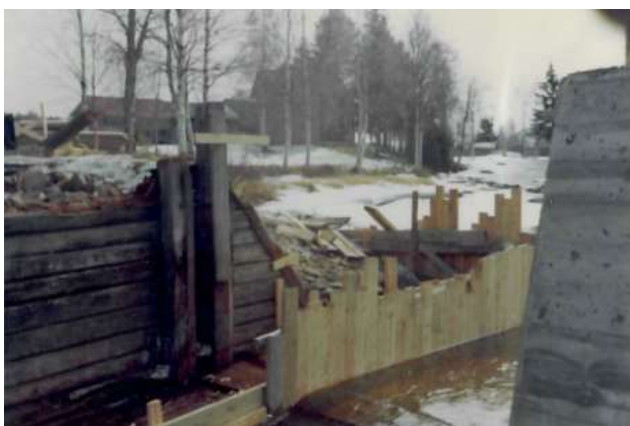
Gammal stenkista och fångdamm för renovering av höger dammpelare.
