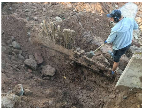
Rivning av gammal murken spont.
