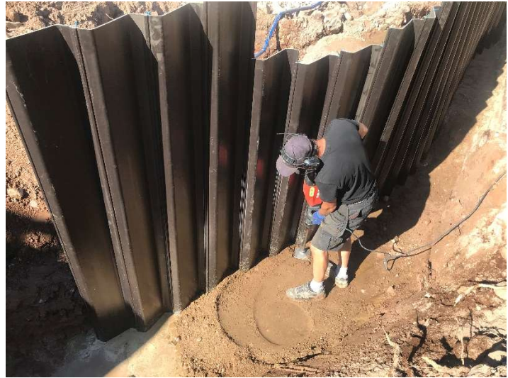
Packning intill spontplankor med platta monterad på bilhammare.
