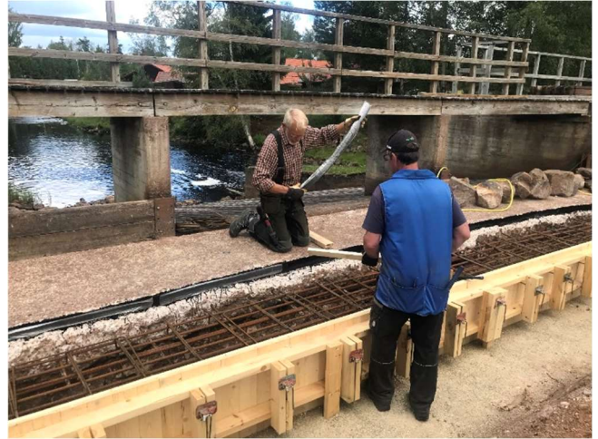
Montering tätningsband (SynkoFlex)
