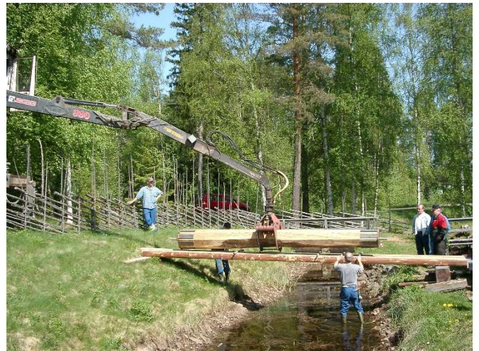
Axeln läggs på timmerstockar för att sedan baxas in på plats.
