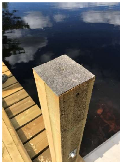
Mellan stolpar och överliggare monterades papp för att skydda ändträet.
