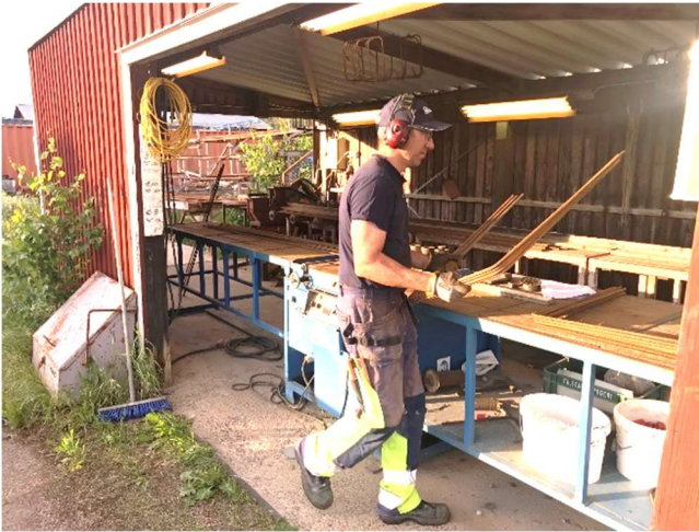
Böckning av armering.
