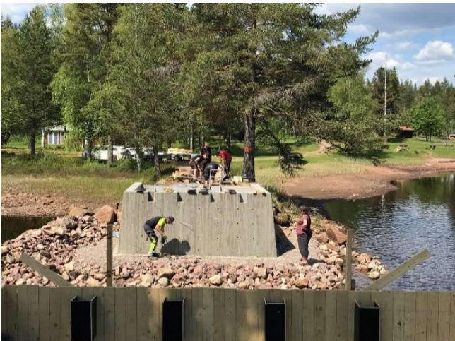
Formrivning västra landfästet genom ideellt arbete.
