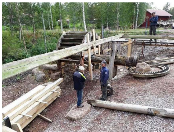
Första stockvarvet provisoriskt utlagt.
