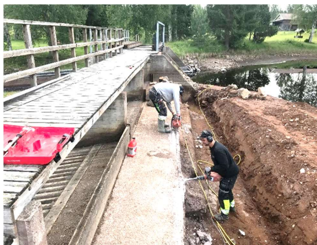
Sågning av skibordskant för att få en plan tätningssyta och borrhning för förankringar för att sammanbinda ny och gammal betong.
